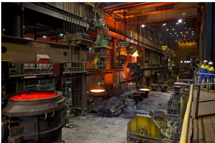
De staalfabriek bij Tata Steel in IJmuiden
