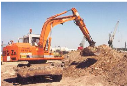
figuur 1: bodemsanering kan op vele manieren gebeuren. Afgraven heeft alleen zin als de verontreiniging zich goed aan de bodem hecht.
